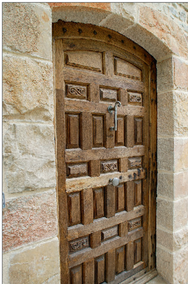
— Restauration porte d'entrée, sablage, vernis teinté - Valbonne.
