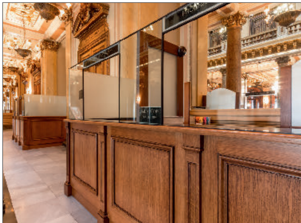
— Banque accueil, façade moulurée, partie haute verre securit, chêne, finition patinée et vernis teinté. Casino - Monaco
