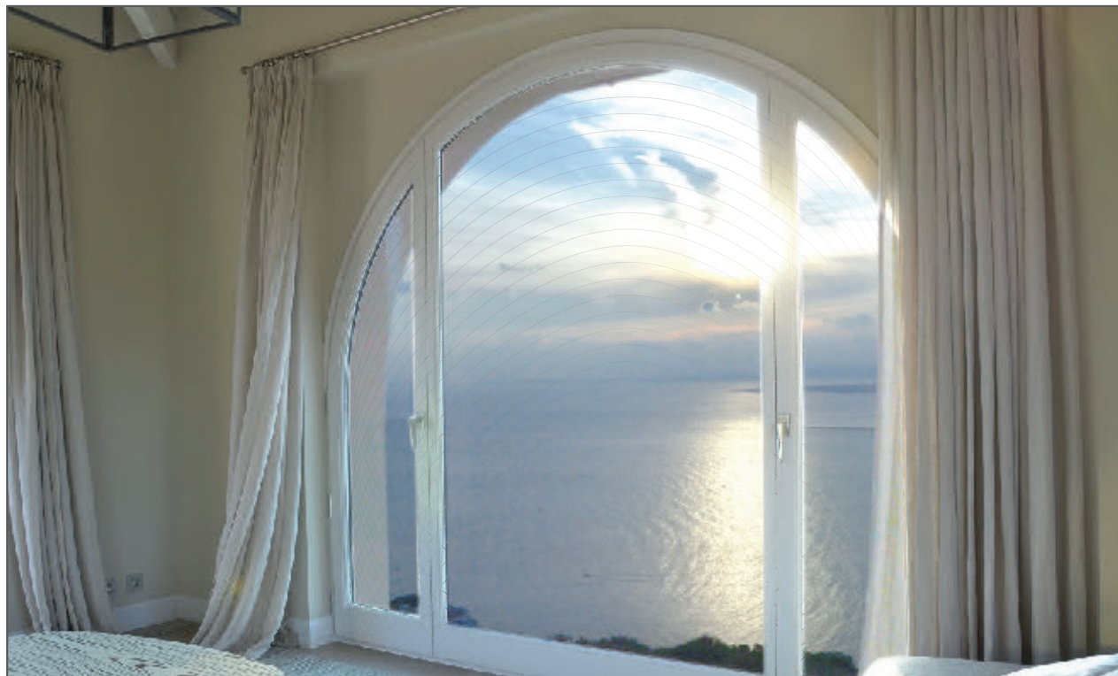
— Portes-fenêtres plein cintre, partie centrale fixe et deux côtés ouvrants, finition laquée - Villefranche-sur-Mer
